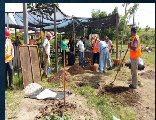
Construcción de Viveros
