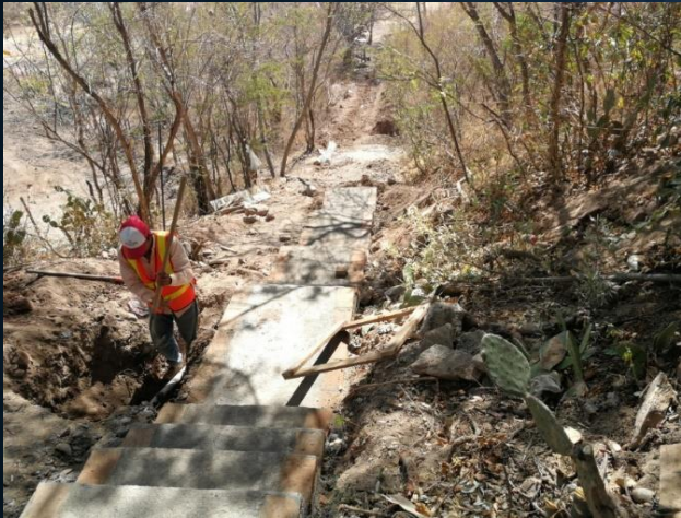
Construcción de gradas
