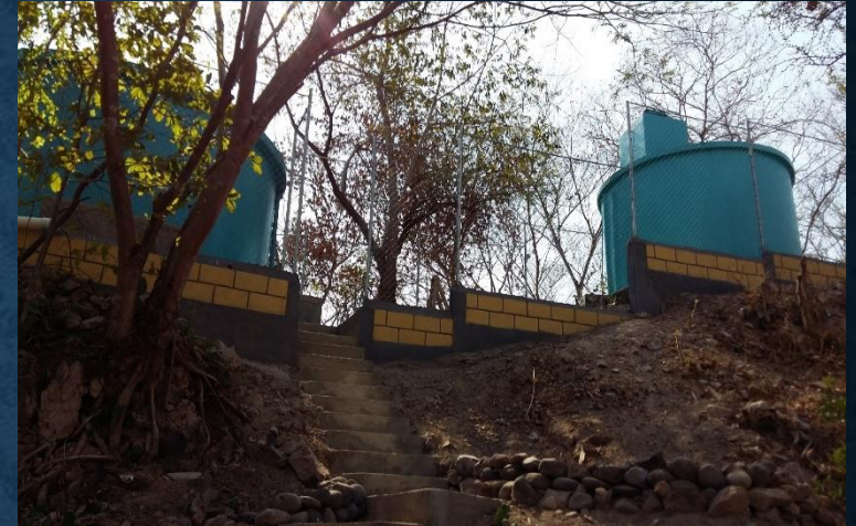
Pintado de Muro Perimetral a Tanques
