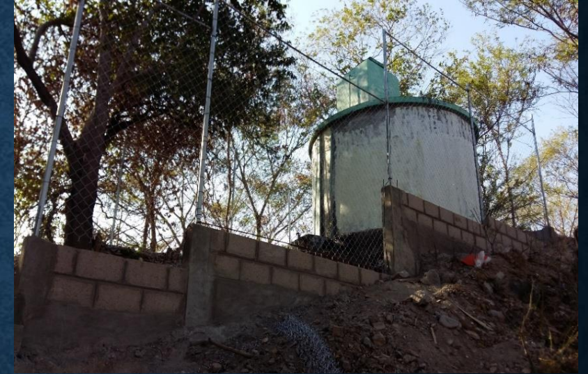
Construcción de Muro Perimetral - Tanques
