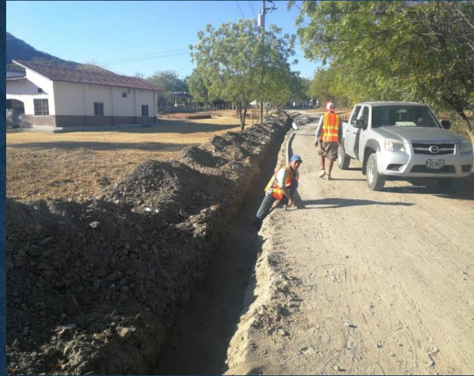
Remodelación de la Red de Distribución de Agua Potable
