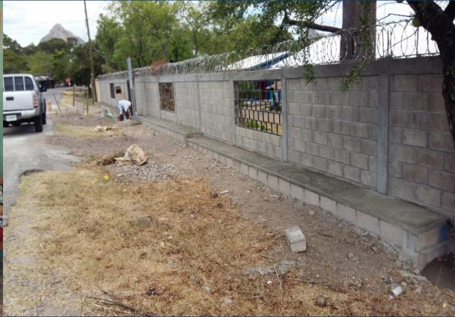
Construcción de Acera
