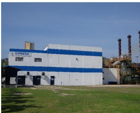
En el año 2004 la empresa **ELASTICOS CENTROAMERICANOS Y TEXTILES, S.A. DE C.V. (ELCATEX, S.A.)** Ubicada en el municipio de Choloma, Cortes, construye su propia planta de generación de energía eléctrica instalando dos (2) motores de combustión interna marca **MAK-Caterpillar**, modelo **16CM32C** de **7,210 KW** cada motor. En el año 2005 se amplía la planta con el tercer motor, quedando con una capacidad total de **21,630 KW**.
